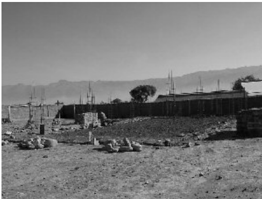
Foto: bouw multi-funcionele ruimte
