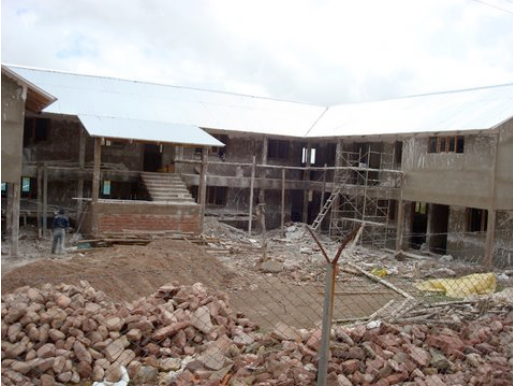
Foto: de bouw van het internaat in Pongo.
